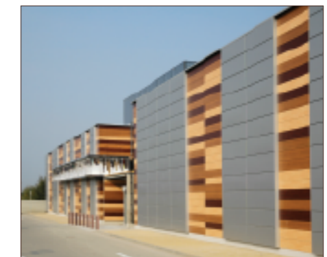
Рестаурація старих будівель (мінімум навантаження на стіни і фундамент)
