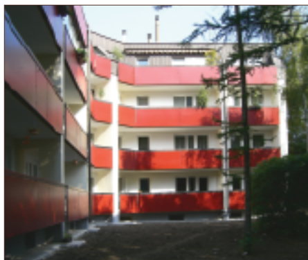
Зовнішнє облицювання стін і балконів, дверей і воріт
