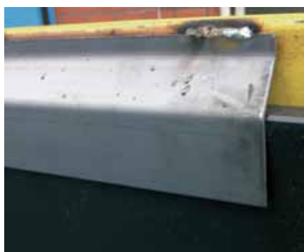
Защитная планка предохраняет от попадания сыпучего материала под плиты
