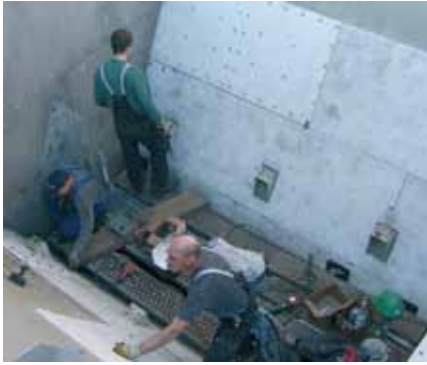
Метод крепления на шпильки с резьбой: футеровка бункера
