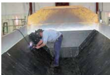
Надежность крепления: установка плит Matrox® в кузове самосвала методом приварных шпилек с резьбой
